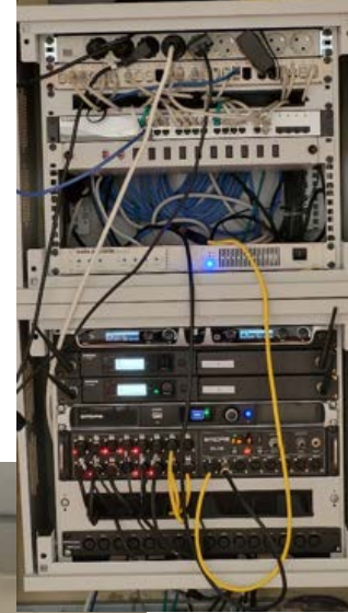
Schaltschrank für Ton, Videoübertragungen, Streaming
