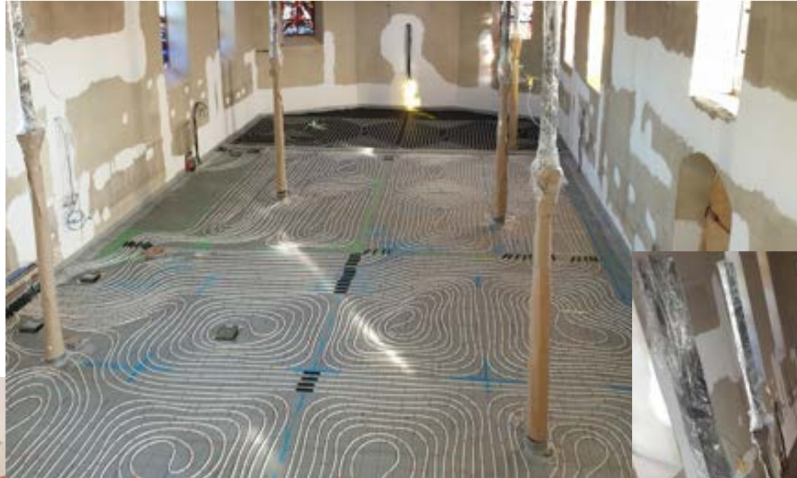
Rohrleitungen der Fußbodenheizung
