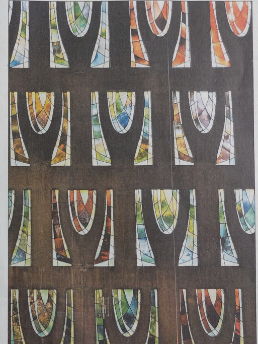
Die Bezirkssynode tagte im Gemeindezentrum der Lukaskirche in Süd. Die Fassade des Gotteshauses aus buntem Glas und Beton wurde vor wenigen Jahren aufwendig saniert. FOTO: EVO
