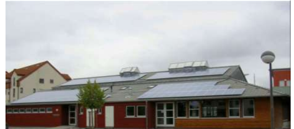
Prot. Gemeindehaus, kein Schatten, neues und einfach zu erreichendes Dach Foto: Klingberg-Adler
