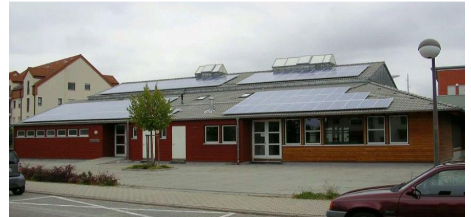
Prot. Gemeindehaus, kein Schatten, neues und einfach zu erreichendes Dach
