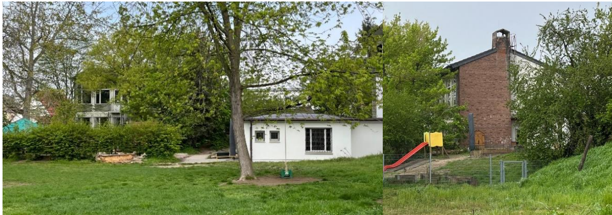
Prot. Kita Dach alt und teilweise verschattet
